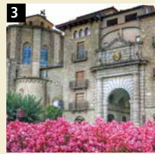
Portal del Pont. Queden en peu restes de les primeres muralles disperses en diferents indrets, així com les tres torres a la zona del Vall Calent. S'accedia al recinte emmurallat pels portals que es tancaven al capvespre
