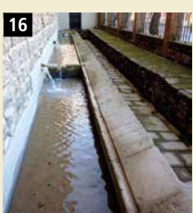
Lavaderos. Ya antiguamente existía una balsa junto al portal del castillo, fuera murallas, que las mujeres utilizaban para lavar. En 1779 se restauró y se le dio forma de lavadero. La reconstrucción actual es de 1994.
